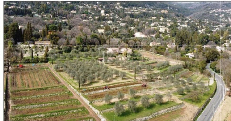
Les travaux en cours sur le nouveau Domaine de la rose by Lancôme concernent la réhabilitation du terrain agricole de 4 hectares, mais aussi de son système d'irrigation et de ses restanques séculaires.
